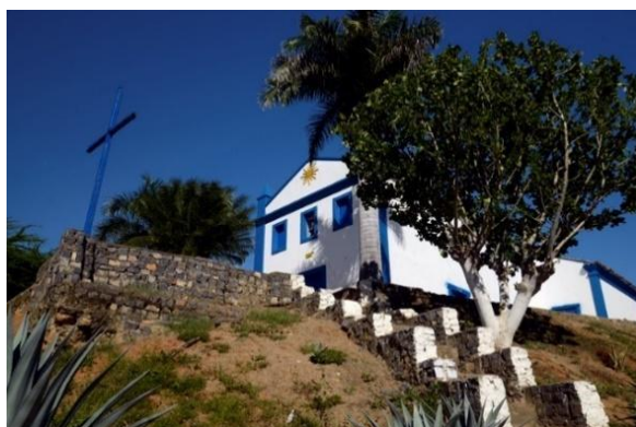
Figura 04: Capela de Nossa Senhora da Conceição
